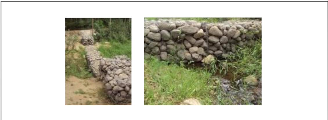
Figura 16. Dique de regulación de caudal en estero el Olivar (Elaboración propia, 2011).
